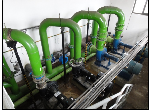
Nyomásfokozó szivattyúk és szerelvényeik
