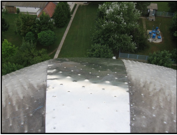
Víztorony külső felületének szigetelése
