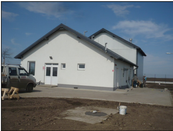
Gépház, szoc. ép., vegyszeradagoló, 2 x 250 m 2 tároló
