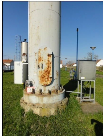
Bebúvó nyílás felületi korróziója
