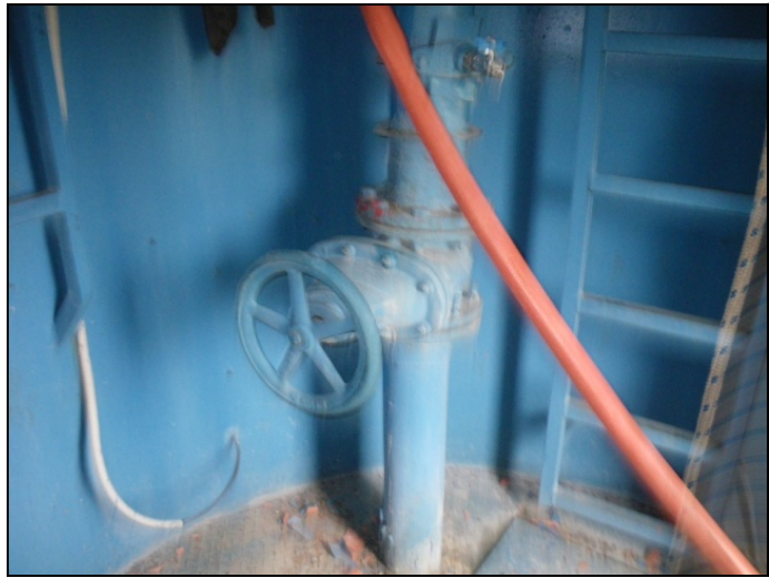
Elzáró szerelvény
