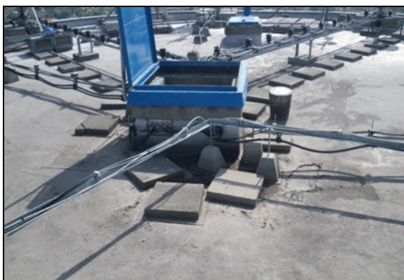
Víztorony tetején kialakított búvónyílás
