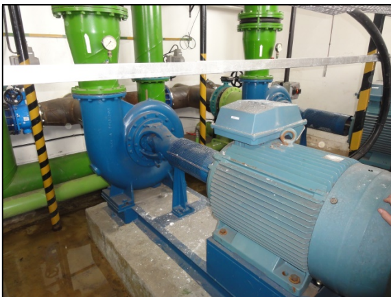
Meglévő ETA-R 300-400 típusú nyomásfokozó szivattyú
