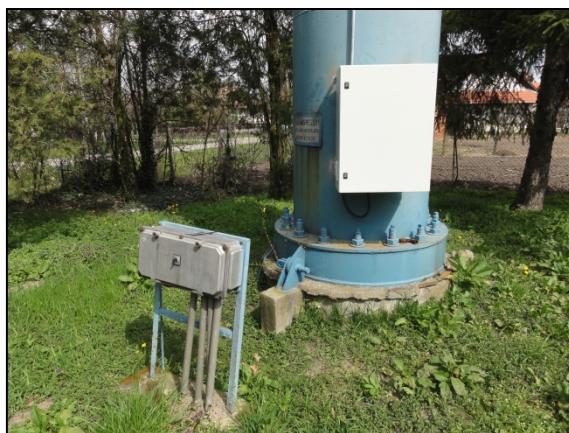
Új GSM alapú bejelzés elektromos szekrényvel és antennával
