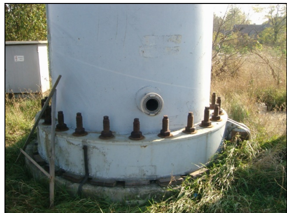
A víztorony lábának kialakítása
