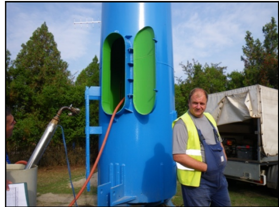
Szerelőnyílás és a toronyszár festése
