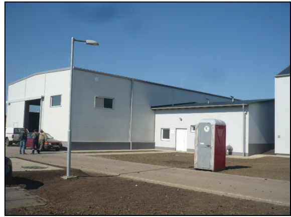
Szociális épület vízkezelő csarnok
