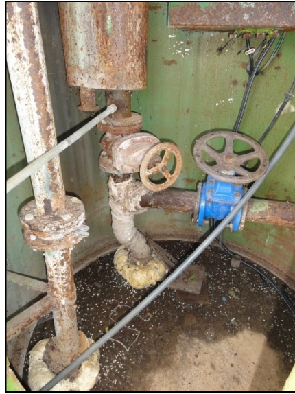
Töltő – ürítő vezeték rossz állapotban
