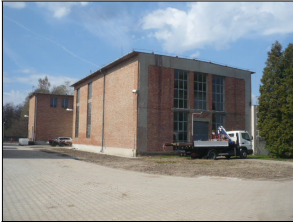
technológiai épület és szivattyú gépház
