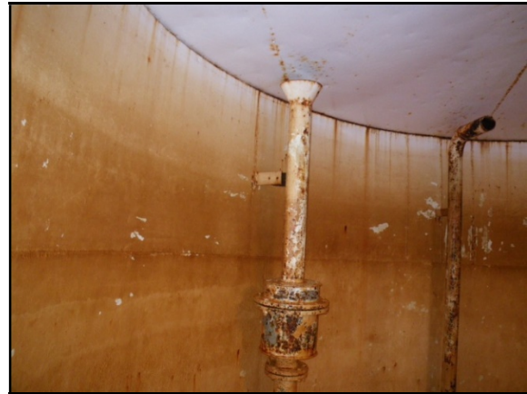
Túlfolyó és víztér
