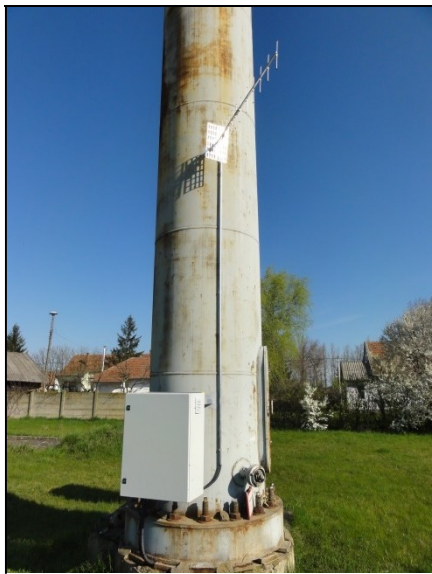
Új GSM alapú bejelzés elektromos szekrényel és antennával
