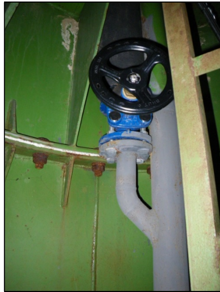
Elzáró szerelvény
