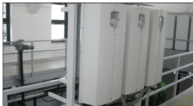
Az új ABB frekvenciaváltók
