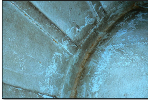
Víztér belső felületének állapota
