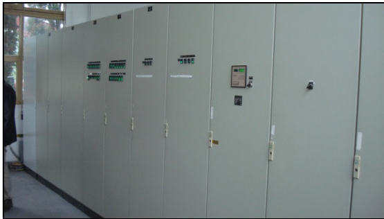
A kapcsolószekrények és az új frekvenciaváltók
