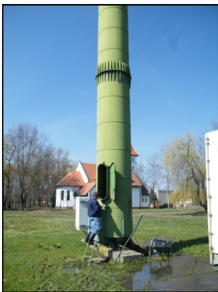
Toronyszár és szerelő nyílás
