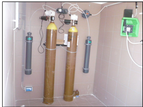
Klór gáz adagoló berendezések
