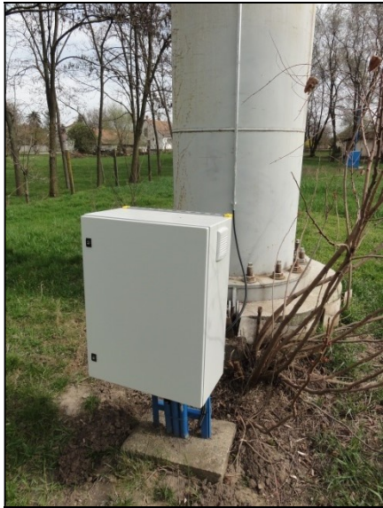
Új GSM alapú bejelzés elektromos szekrénye
