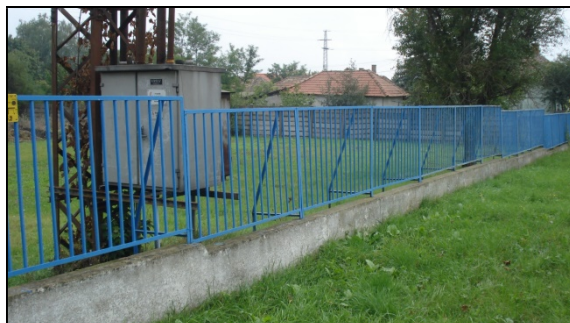
Gyomaendrőd II/A vízműtelep utcafronti kerítés
