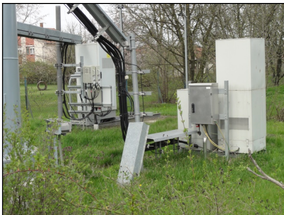
Távközlési elektromos szekrények a torony mellett
