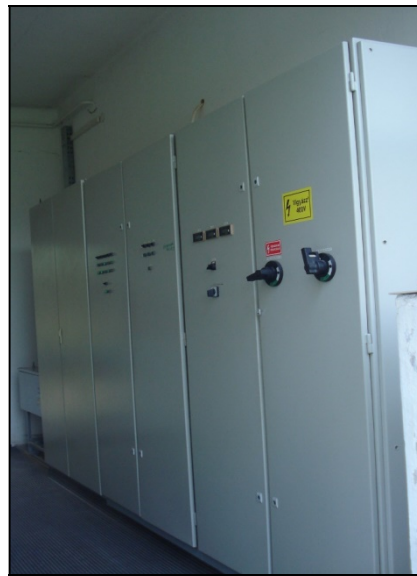
Gyomaendrőd II/vízműtelep nyomásfokozó kapcsolószekrény
