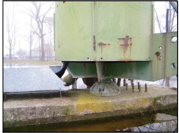
Toronyláb kialakítása
