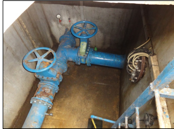
Kézi tolózárak
