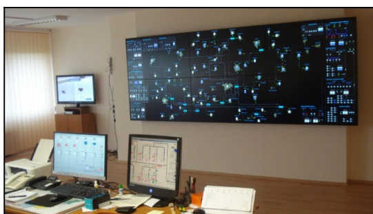
Az operátor állomás a monitor fallal
