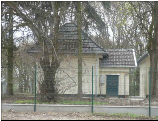
meglévő, felújított vízkezelő épület
