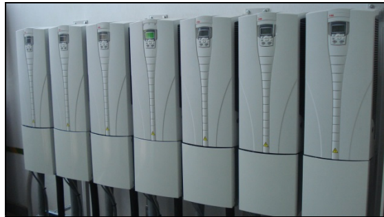
A kapcsolószekrények és az új frekvenciaváltók
