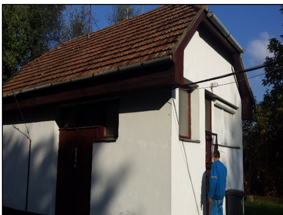
IV.sz. vízműtelep - Kezelőépület
