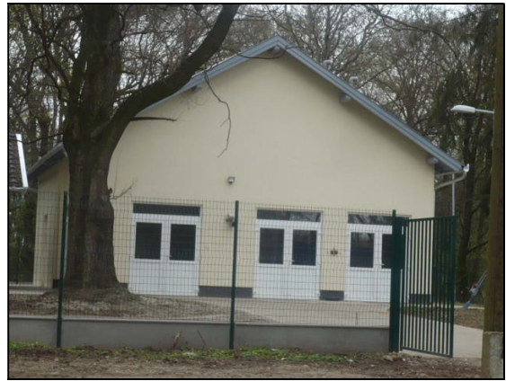
új vízkezelő épület
