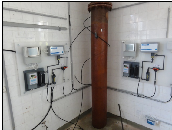
Klór-gáz adagoló berendezés
