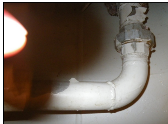
Pergő festékréteg a szerelvényeken
