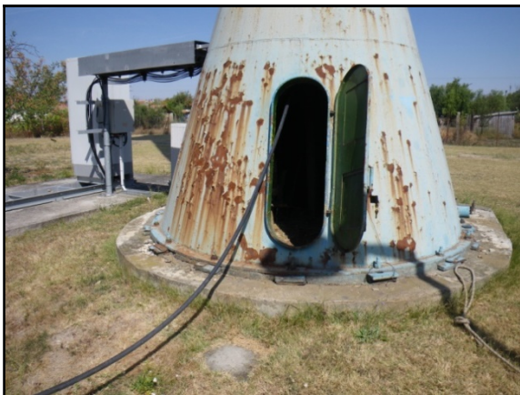
Víztorony szerelőnyílás
