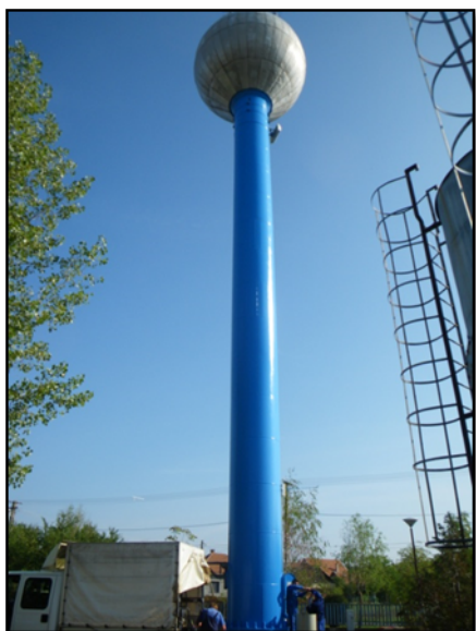
A víztornyó látképe
