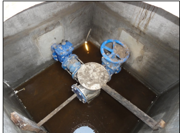
Új tolózár akna szerelvényei
