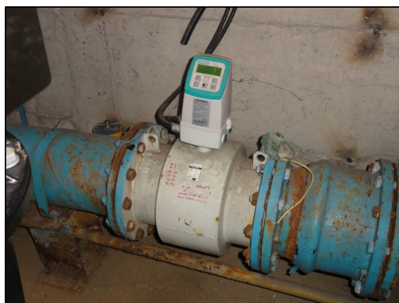
Siemens Magflo átfolyásmérő
