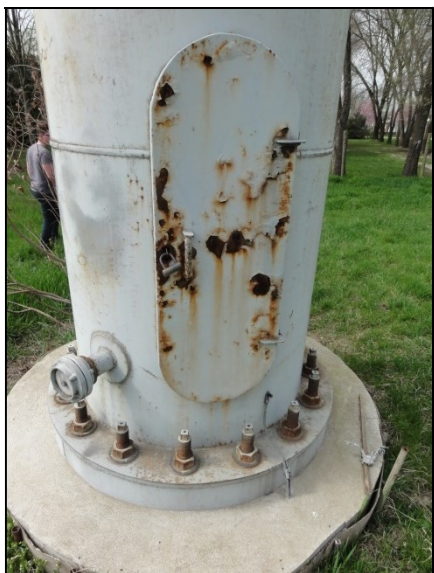
Bebúvó nyílás felületi korróziója
