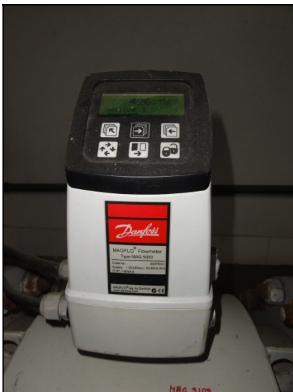
Danfoss MAGFLO átfolyásmérő
