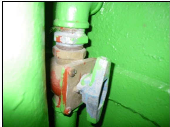
Elzáró szerelvény
