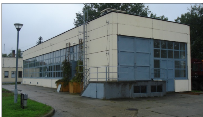
A vandhāti telepen lévő főgépház épülete
