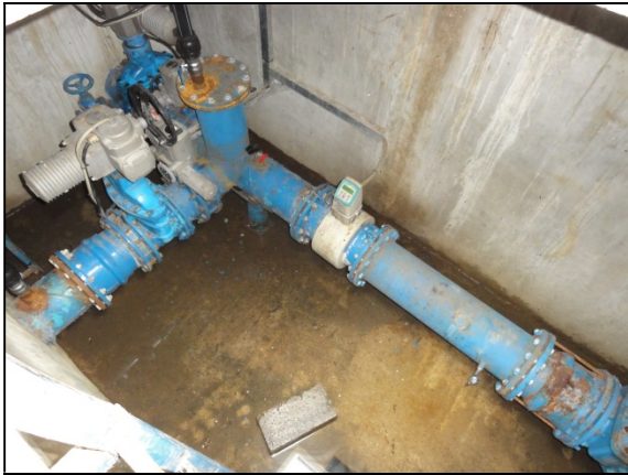
Átfolyásmérő és AUMA tolózárak
