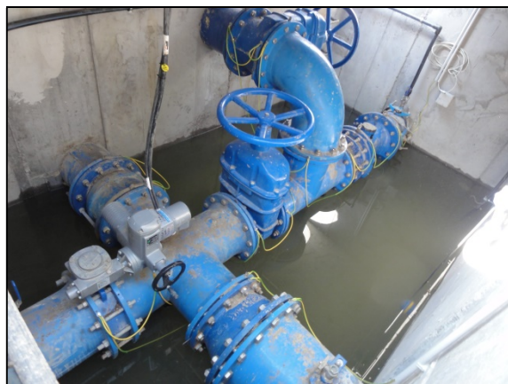
Udvartéri kormányzó akna szerelvényei
