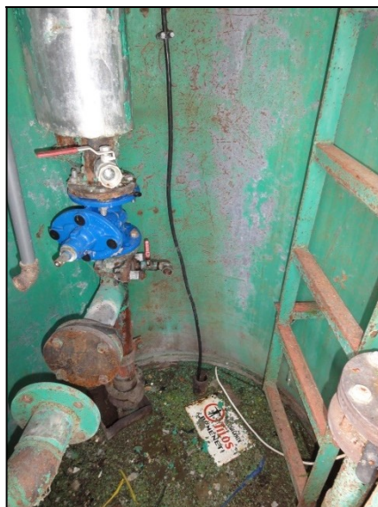
Toronyszár szerelvényei
