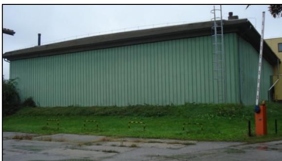
A 2 db 2500 m 3 -es tároló a zárkamrával és klórtárolóval
