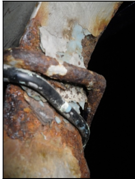
Szerelvénykorrózió
