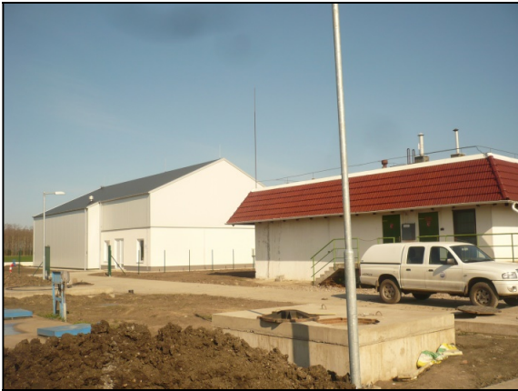
Új szivattyúház, 2 x 500 m 3 -es tározó
