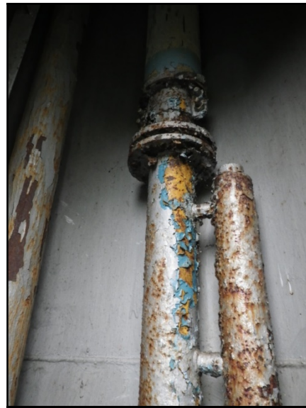
Szerelvénykorrózió
