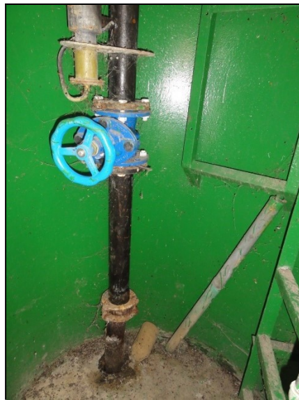
Elzáró szerelvény
