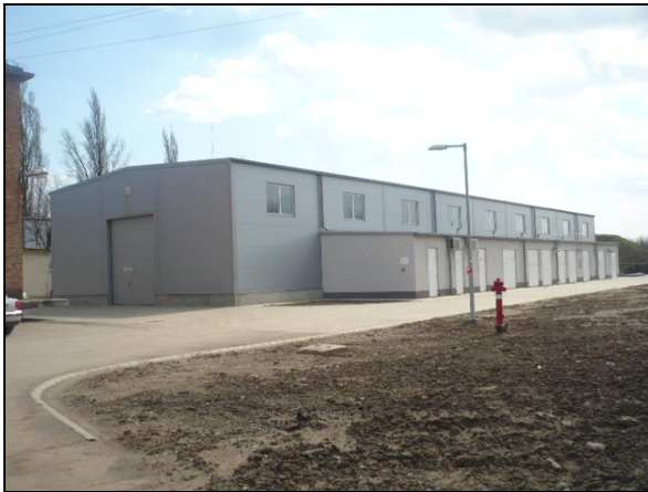
vízkezelő épület I:, toldalék
