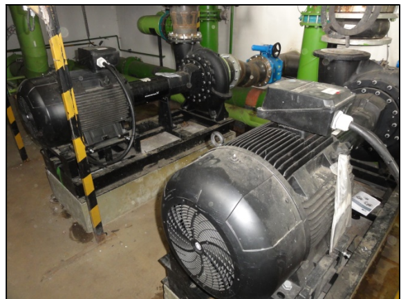
Nyomásfokozó szivattyúk és szerelvényeik
