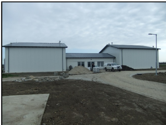
gépház, szoc.blokk, vegyszer adagolók, 4 x 500 m 3 -es tároló
