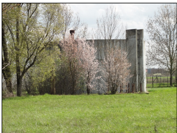
600 m 3 -es vasbeton tároló
