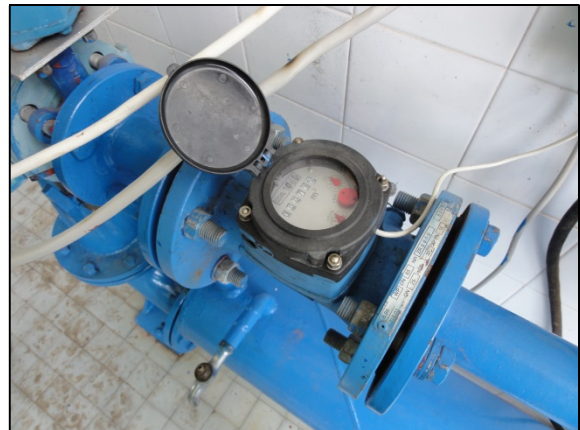
DN65 Átfolyásmérő berendezés
