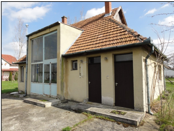
Üzemen kívüli gépház, amelyben az átadási pont található
