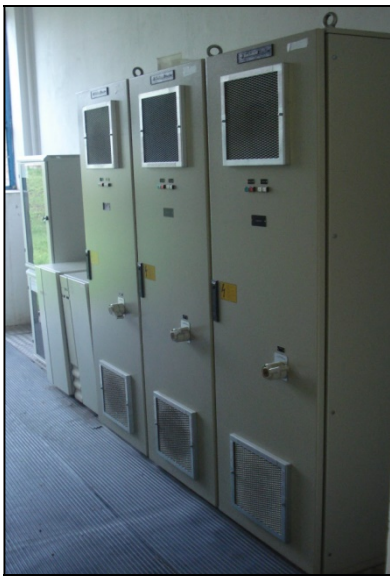
Gyomaendrőd II/vízműtelep nyomásfokozó kapcsolószekrény
