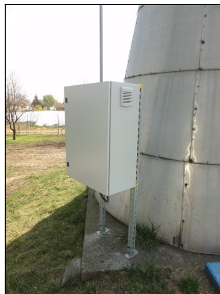
Új GSM alapú bejelzés elektromos szekrénye
